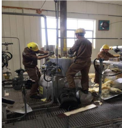
拆卸爆破片
