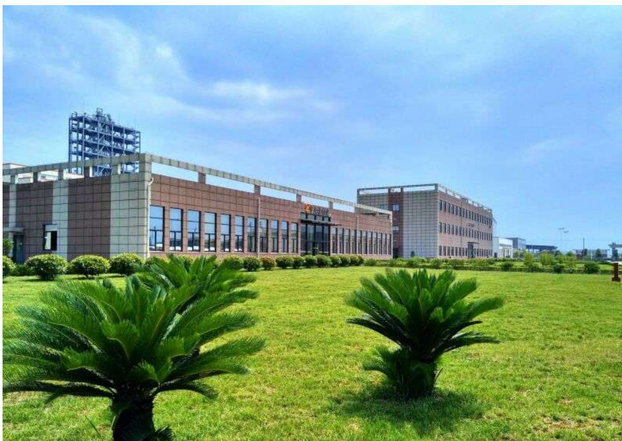
氟化厂中央控制室
