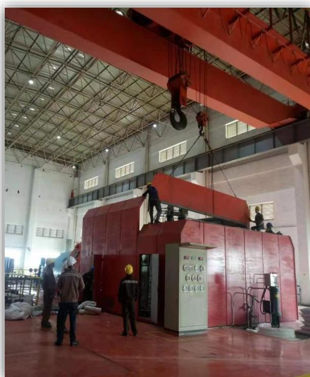
运行，假期结束后，3#锅炉烟道检修完成并开 3#发电机，2#、3#发电机一起运行。但，计划赶不上变化，3#汽轮机如期开启了，因为是背压机，需要一定的蒸汽负荷才能带动发电，由于热负荷较低、工业园区用汽用户较少，再加上新发电机第一次带负荷，11-13 日期间接连发生多次跳停，热车间顿时压力山大。在此紧要关头，总经理接连召开会议，很多干部放弃周末假日，研究对策，齐头并进，全力以赴抢修 1#机，缓解 3#机运行的被动局面！期间还遭遇 3#发电机水冷却器漏水、厂家要求拉回上海维修等需要极大的勇气和风险担当的抉择问题！而我们的员工硬是一片一片拿
